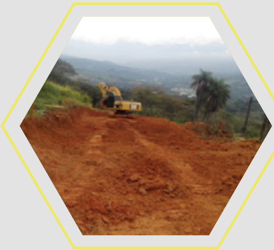
Fotografía 6 Área de excavación Poblancó
